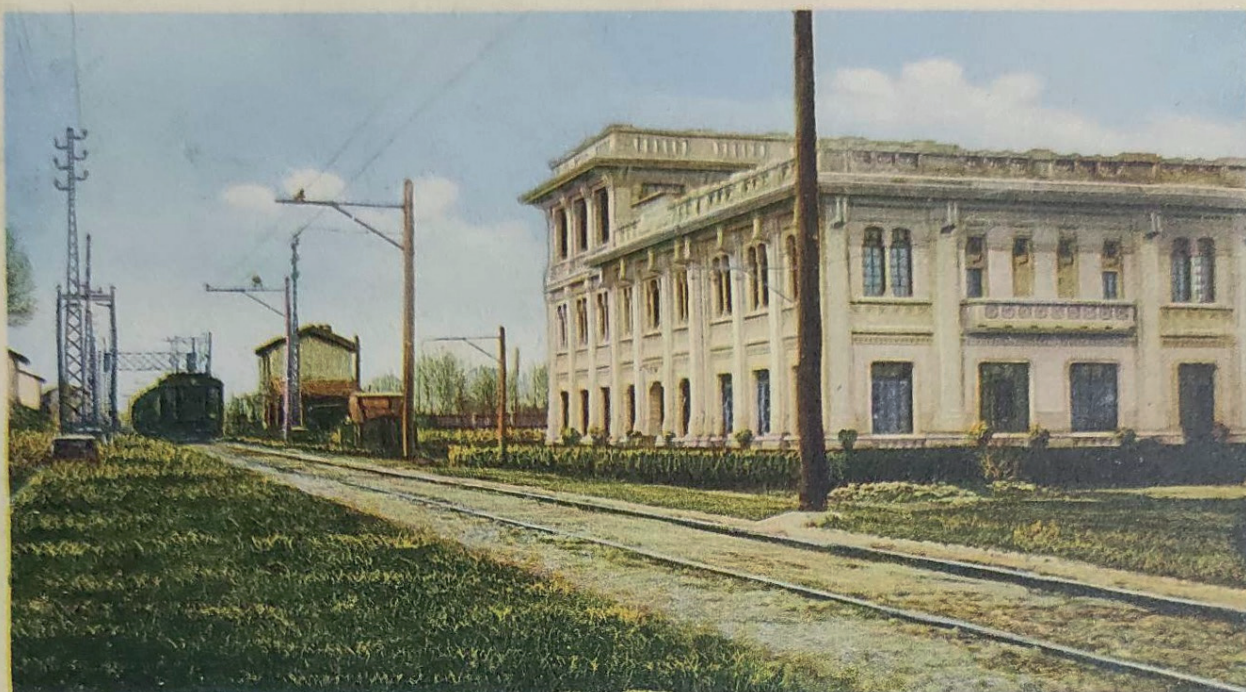
CIRIE' - Centrale elettrica
